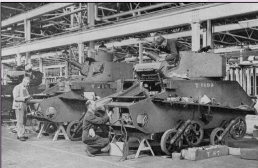
▲ Mark VIB's in revisie bij de MG autofabriek in Abingdon, Berkshire, die deel uitmaakte van het Nuffield concern. Vanaf het midden van 1940 werden meer dan 100 tanks grondig gereviseerd voordat ze weer werden toegewezen aan de pantserdivisies in Groot Brittannië en in Noord-Afrika.
